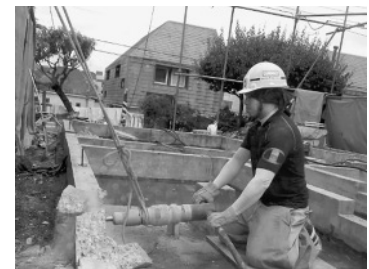
コンクリートブレイカーを使用
