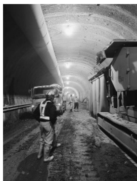
霧がかったような切羽付近
