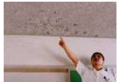
子ども達が突いたりして破損している吹き付けアスベスト
