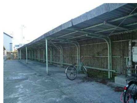
学校の駐輪場の屋根はスレートが今も多い。
